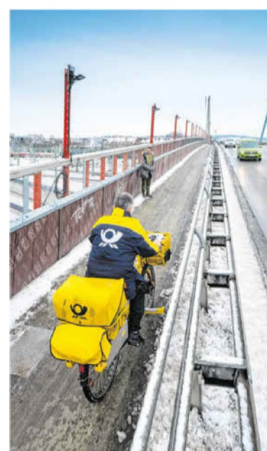
Die Schutzplanke kommt weg, der Geh- und Radweg wird breiter. Foto: Volkmar Könneke
